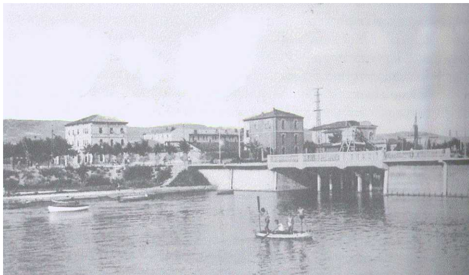
Ponte carrozzabile prima della chiusura della testata
