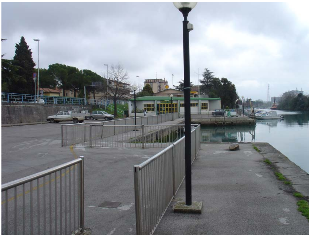
La Banchina del Porto come si presenta oggi
