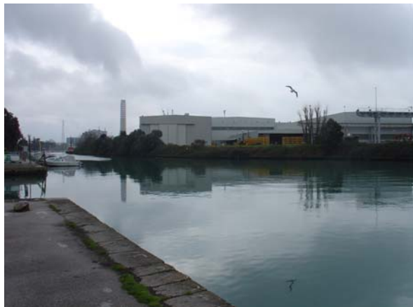
Vista stabilimento Fincantieri e Parco Lamiere
