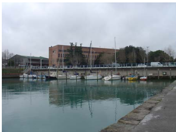
Testata del canale
