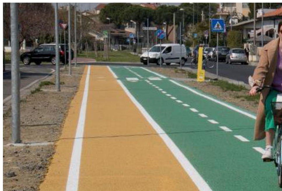
Percorso ciclopedonale realizzato su ex ferrovia Fincantieri - via Aquileia
