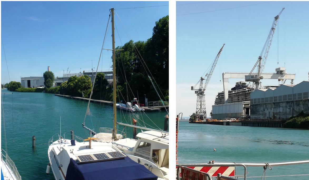
- foto a sinistra: il pontile della Capitaneria di Porto e la sponda con vegetazione spontanea e incolta che separa il canale dall'area del Cantiere Navale - foto a destra: al termine dell'area progetto il rapporto tra il Cantiere navale, le sue movimentazioni (rimorchiatori, varo grandi navi,...) è diretto e l'immagine fortemente industriale caratterizza indiscutibilmente il paesaggio verso il mare Adriatico
