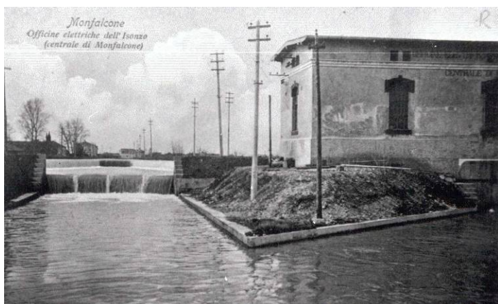
Centralina idroelettrica al termine del Canale irriguo de' Dottori
