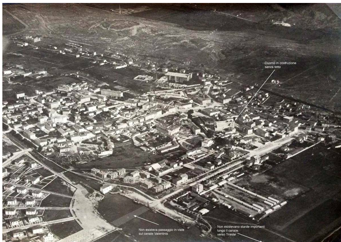
3. la situazione del porto canale Valentinis prima della costruzione del ponte
